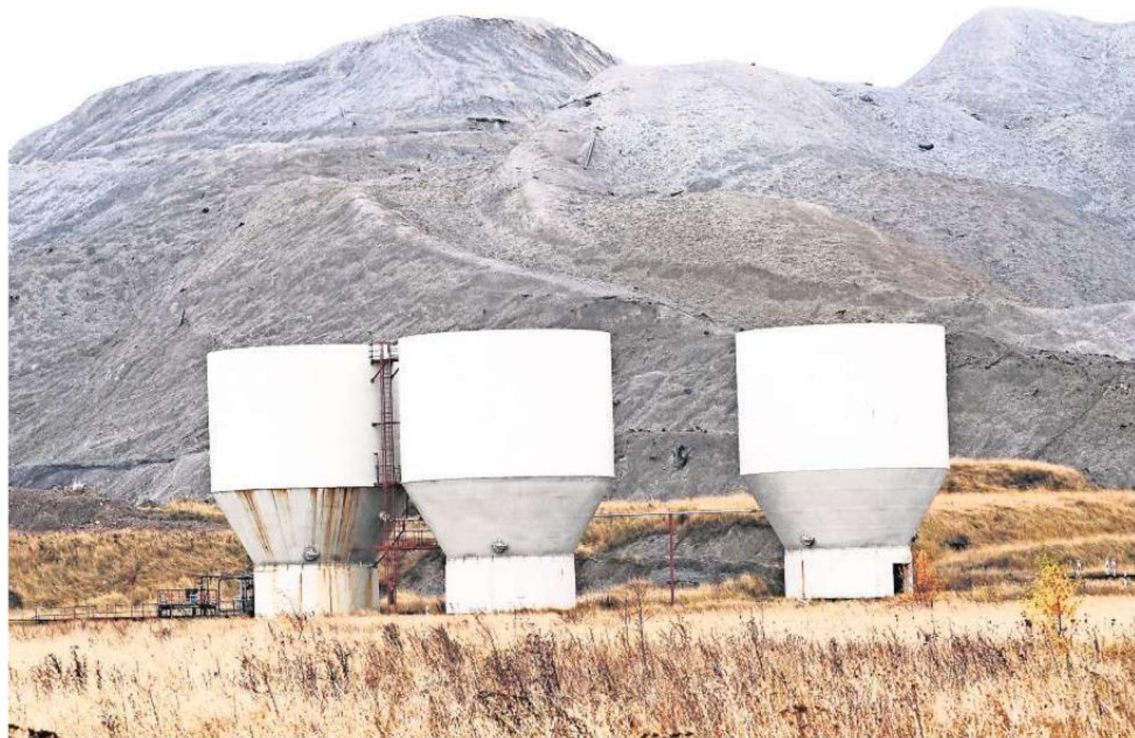
Unter anderem mit diesen Sammelbehältern fängt K+S Wasser am Kaliberg auf.
