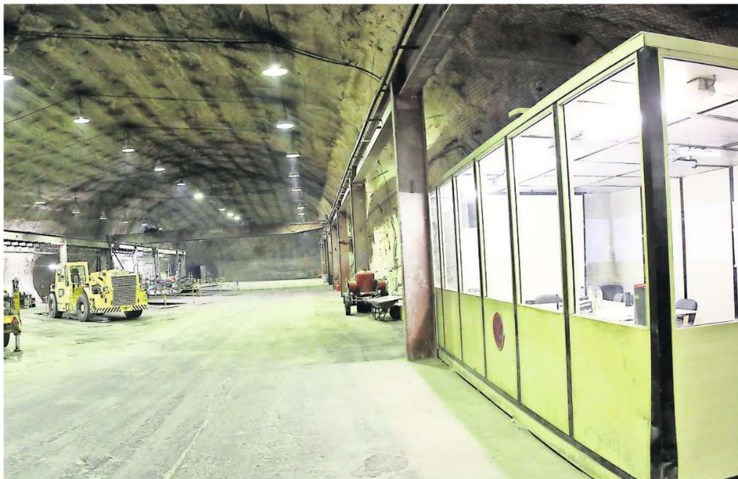
Diese Bürocontainer im Kalibergwerk sind ausgebrannt.
