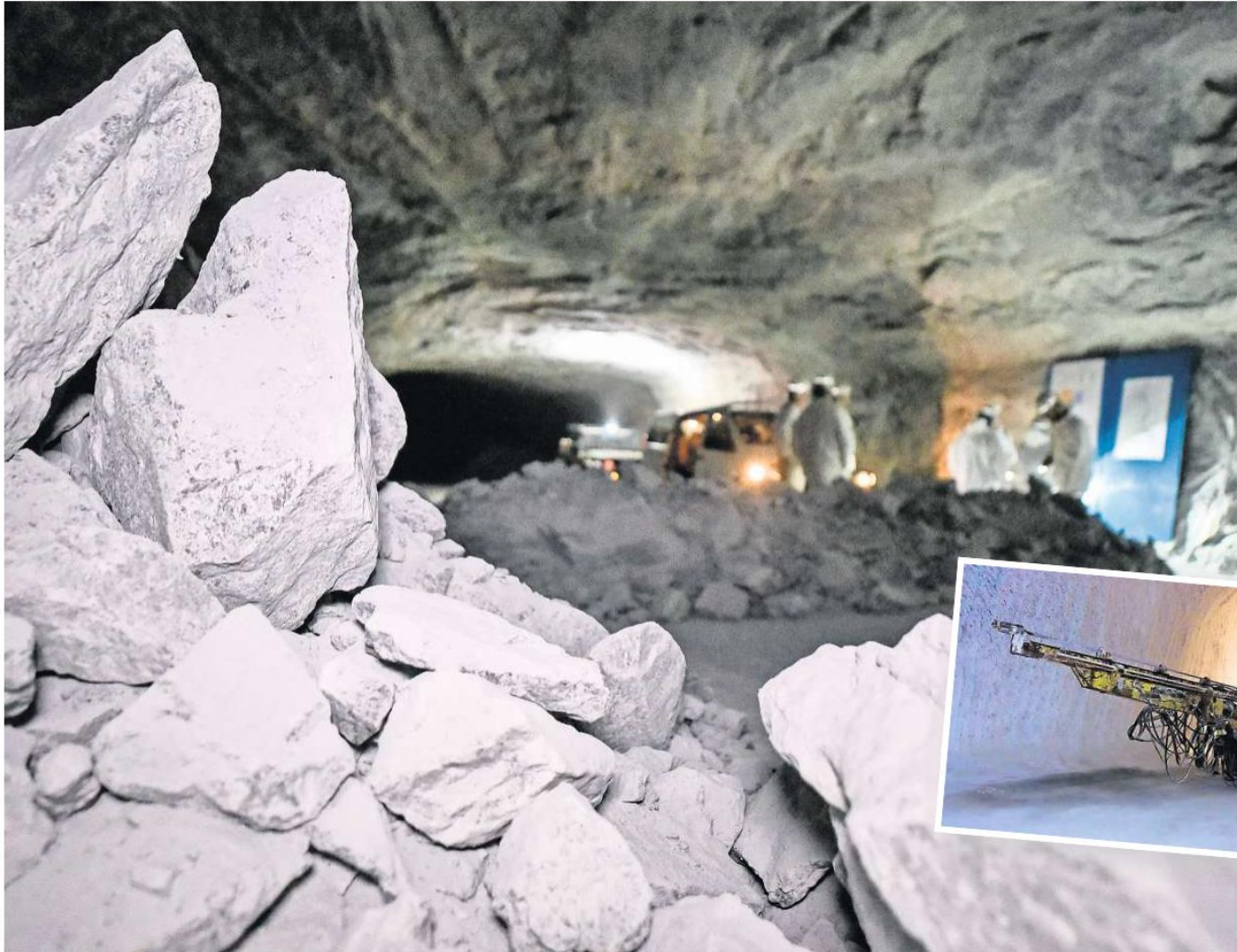
Blick ins Innere, tief unter der Erde von Giesen: Im Bergwerk wird bald gesprengt.
