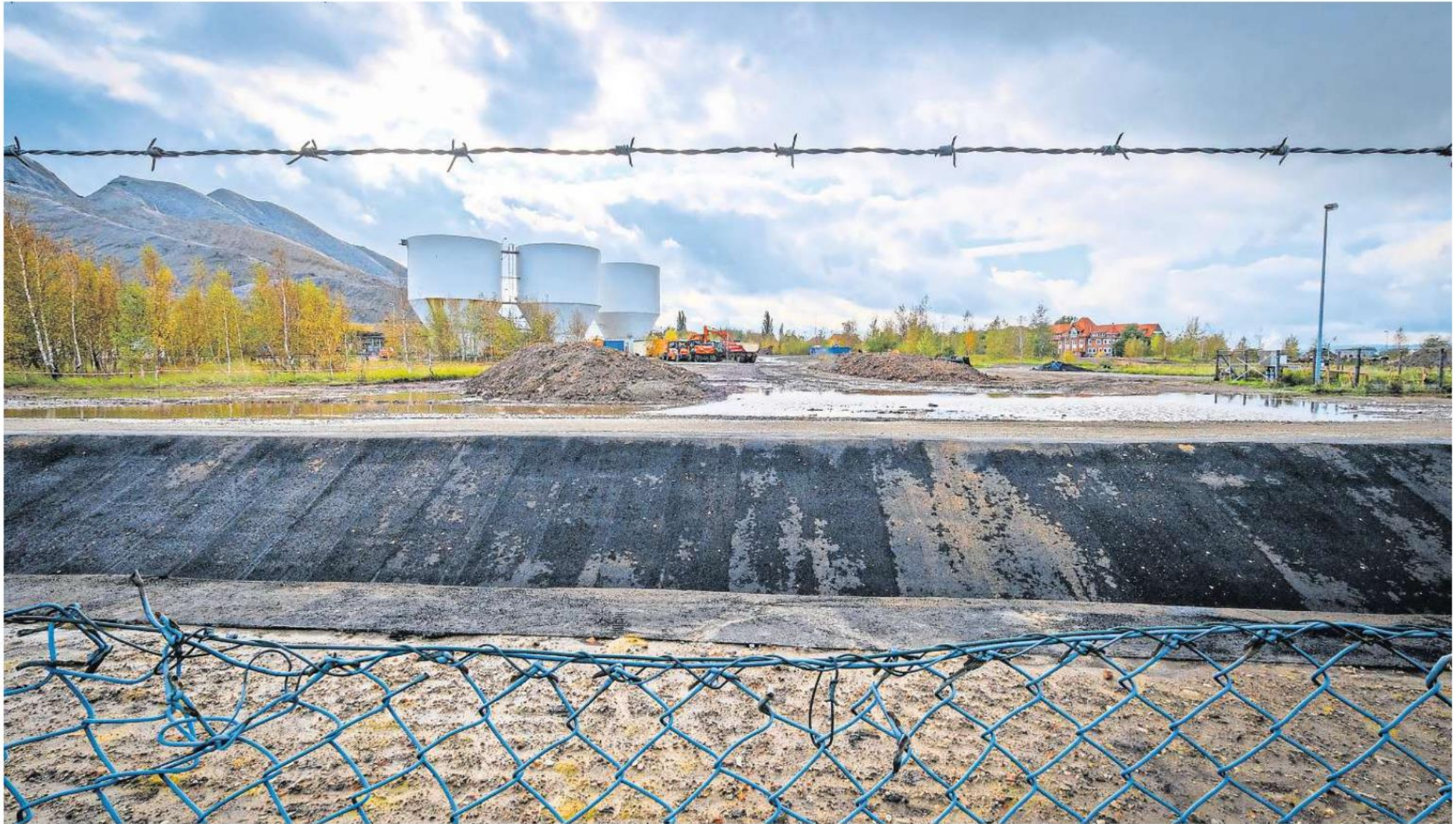
Derzeit werden rund um den Giesener Kaliberg neue Gräben ausgehoben.
