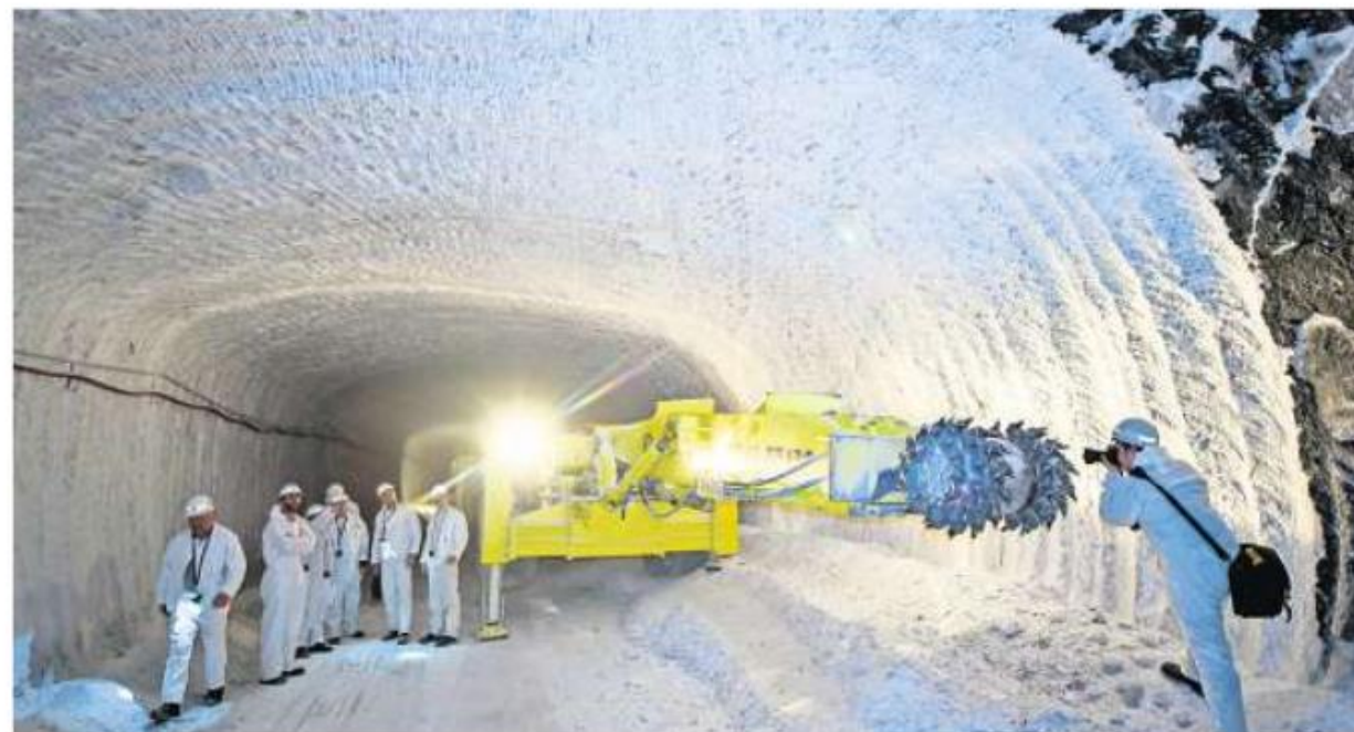
Arbeiten im Giesener Bergwerk: Automatische Brandmelder sind derzeit nicht Pflicht.
