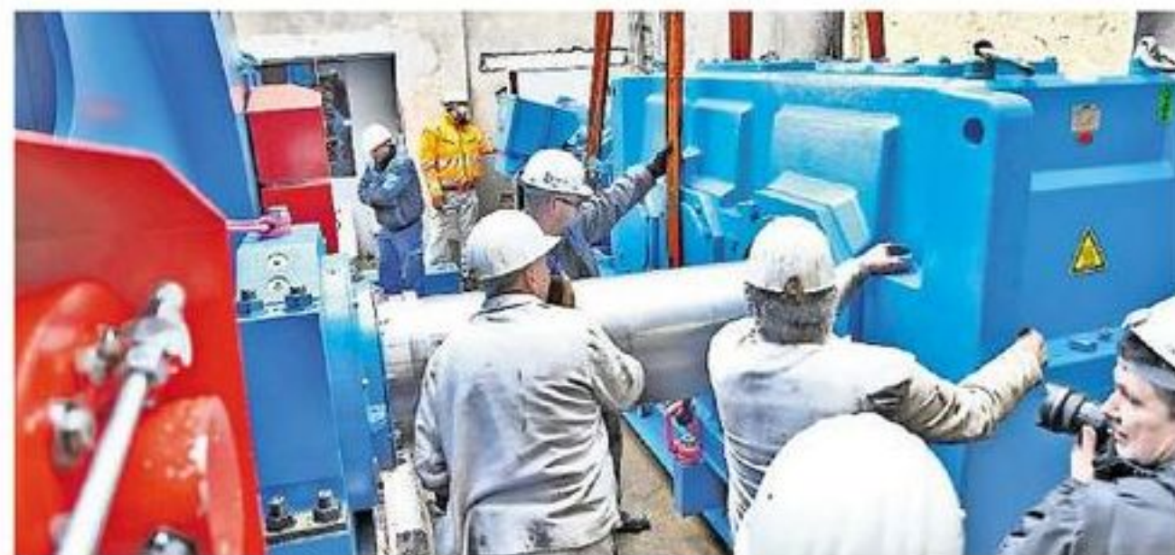
Jetzt ist Millimeterarbeit gefragt, um den 30-Tonnen-Motorblock zu montieren.
