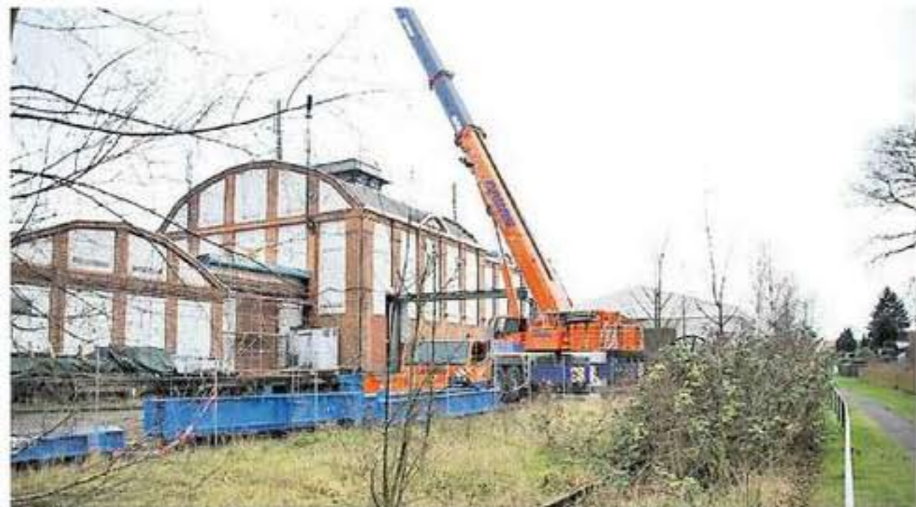
Das Schachtgebäude Fürstenhall in Ahrbergen wird derzeit für die Wiedereinbetriebnahme vorbereitet. Die alte Kalibahn nebenan befindet sich derzeit noch im Dornröschenschlaf. Foto: Knoppik
