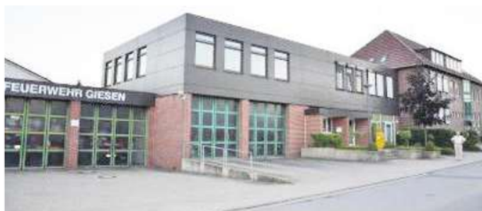
Abriss geplant: Das Giesener Feuerwehrhaus und Rathaus.
