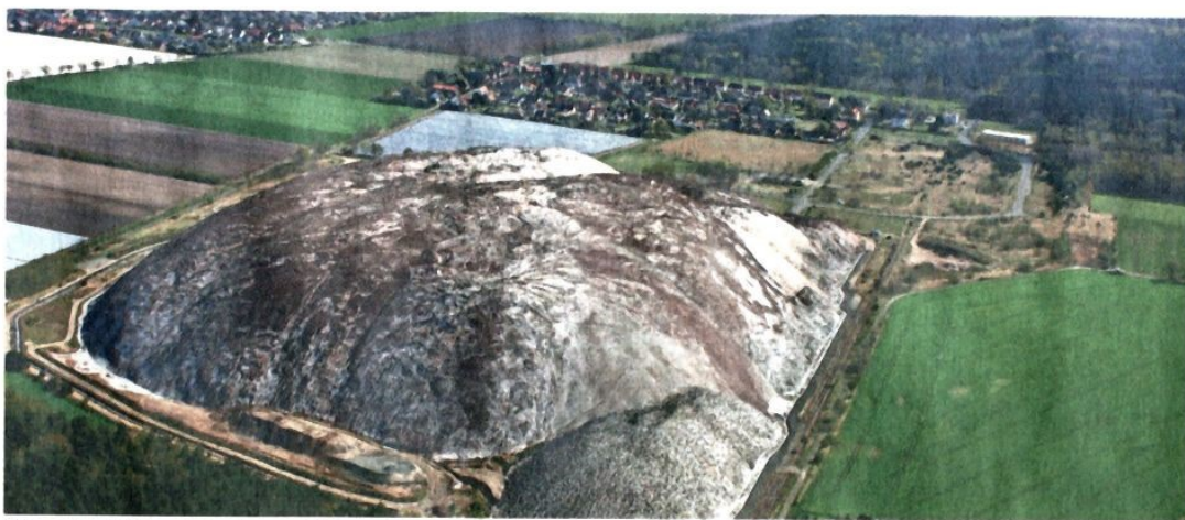
Wenn die Haldenabdeckung mit Bauschutt und Bodenaushub abgeschlossen ist, wird die Grundfläche des Kalibergs doppelt so groß sein wie auf dieser Aufnahme. Links oben am Horizont ist Wathlingen, am Südwestfuß der Halde sind die Häuser von Wathlingen-Kolonie zu sehen.
