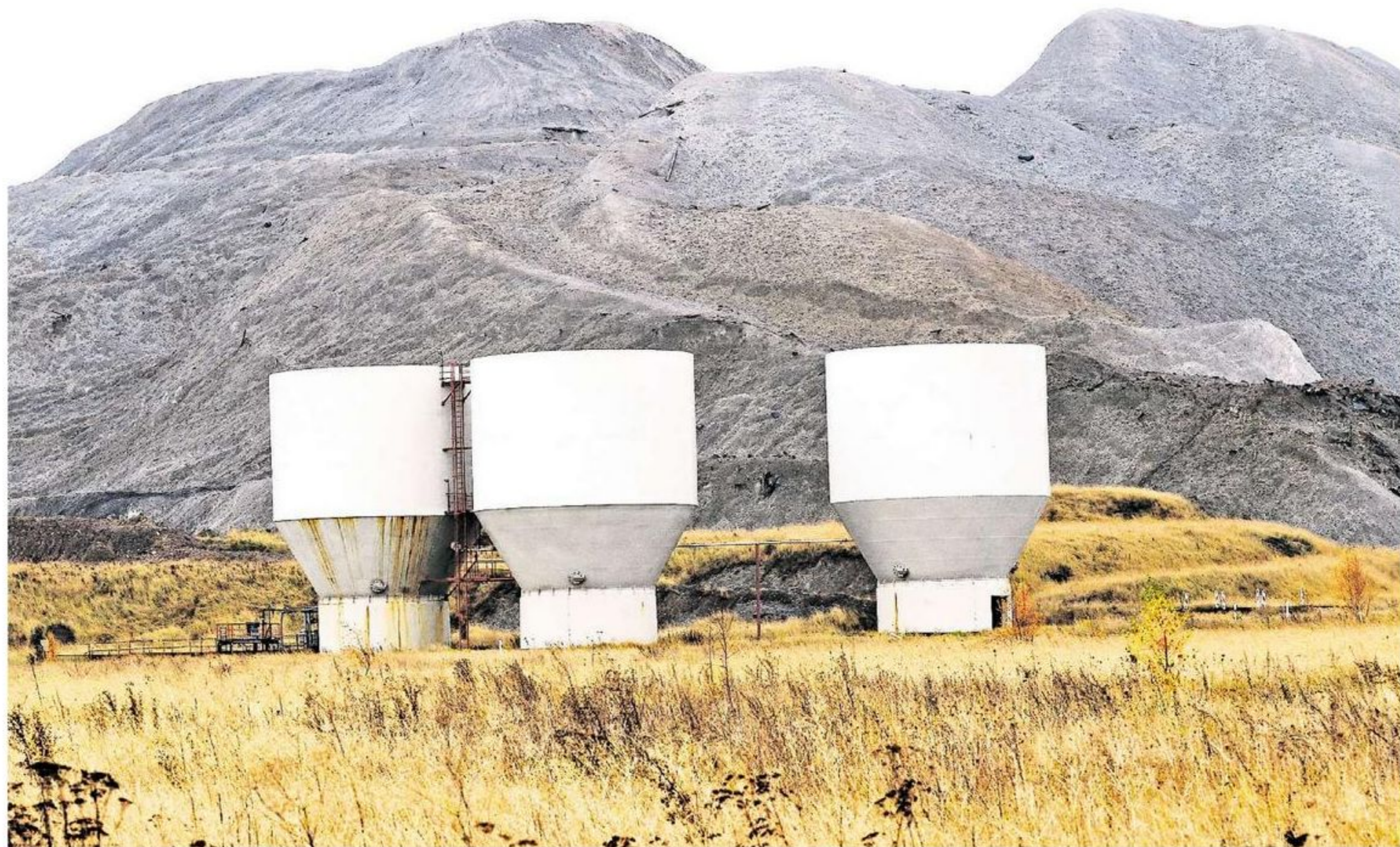
In drei Sammelbehältern fängt K+S Wasser vom Giesener Kaliberg auf. Mehr Rückstände als bislang dürfen nicht in die Innerste geraten – eine neue Halde müsste deshalb fortlaufend mit Erde abgedeckt werden. Foto: Hartmann
