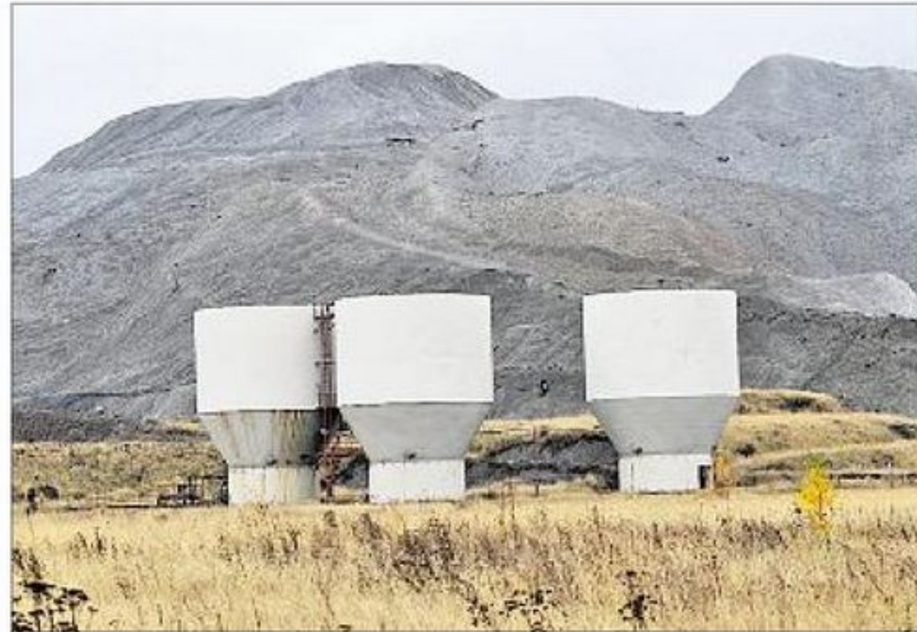
In drei Tanks wird am Kaliberg in Giesen salzhaltiges Regenwasser gesammelt. Foto: Hartmann
